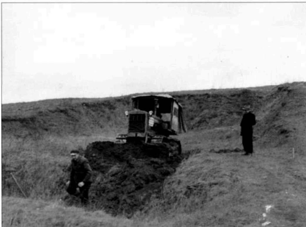
Planierraupen der Firma Claus Alpen beim Ausbau des Scheibenstandes 1954
