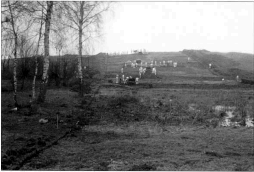
Marinesoldaten beim Ausbau des Schießstandes 1945
