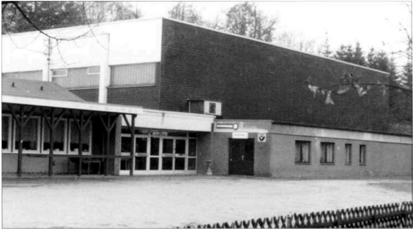
Blick auf das Vordach der Schützenhalle und Schießstandgebäude, 1993.
