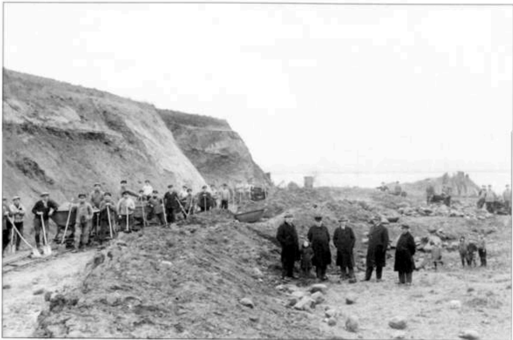
Arbeiten am Poppenberg
