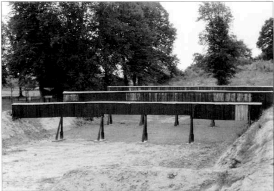
Holzblenden auf dem 1954 ausgebauten Scheibenstand
